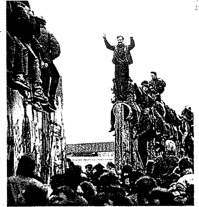
Mauer- Öffnung in Berlin
